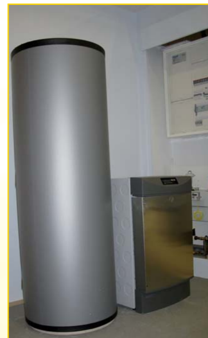
Een voorbeeld van een micro-WKK systeem, hier opgesteld in ons laboratorium
